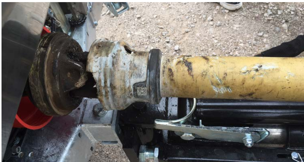
Bild 3. På bilden saknas en del av skyddet och den högra delen är skadad. Här ska den första åtgärden vara att se till att ett helt och fungerande skydd monteras.
