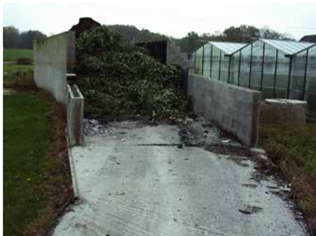
En kompost bör ligga på ett hårdgjort underlag med möjlighet till uppsamling av lakvatten.
