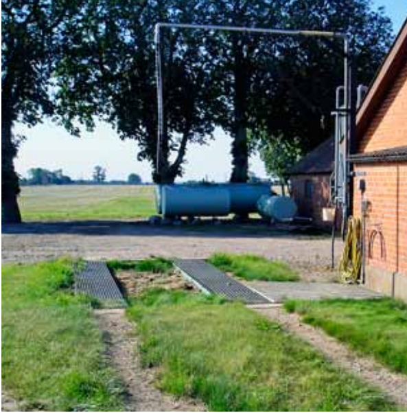
En plan avsatts av gallerdurk där du står och fyller på sprutan minskar risken för olyckshändelser.
