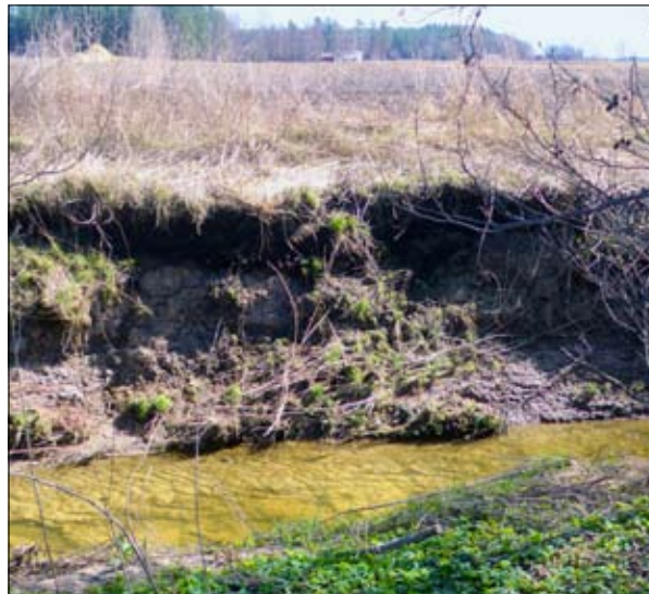
Vattnet har gröpt ur jorden i strandbrinken. Då är det viktigt att fasa av kanten och se till att ny växtlighet etableras så att erosionen minskar.
